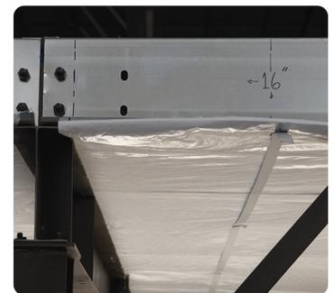
Instale el Clip de Seguridad (Deslizante) (Figura 7D) en este momento. Deslice el Clip Deslizante de Seguridad sobre la banda de seguridad y fíjelo a cada viga usando un sujetador Tek 2. Abarcará las bandas de seguridad y está diseñado para permitir que las Bandas de Seguridad se deslicen si se aplica presión. El clip debe alternarse en cada viga. (Figura 7D)
