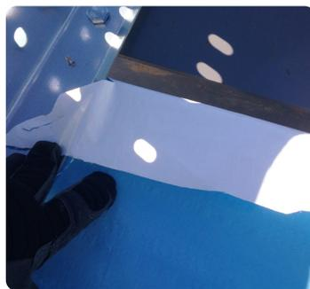
Una la primera capa de tela a la viga de empalme con el adhesivo (BayGrip™ o cinta) suministrado. Una la segunda capa de tela a la viga de empalme encima de la primera capa de tela con el adhesivo (BayGrip™ o cinta) suministrado. Coloque las bandas perpendiculares como se indica en el Paso 6.
